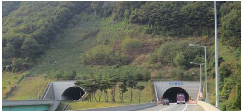
(시점부 절토사면 전경)
